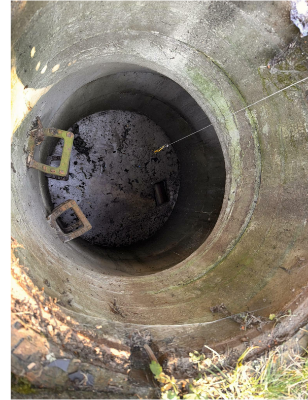
SW-Schacht Bestand Schachttiefe ca. 1,75 m bis Betonsohle + ~0,10 m bis Rohrsohle T = ca. 1,85 m
